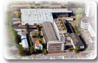
RINGSPANN GmbH, 독일 본부 및 캠 클러치 생산공장
